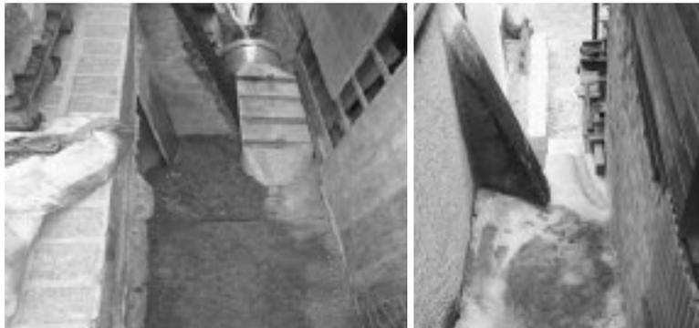
Infolge der tiefer liegenden Werkleitungen in der Baselstrasse kam die Leitung zur Querung der Baselstrasse tiefer zu liegen als vorgesehen. Um die bestehenden Sporne der Nachbarliegenschaft nicht zu verletzen, wurde mit einer Stahlrohrkonstruktion der Engpass gemeistert.
