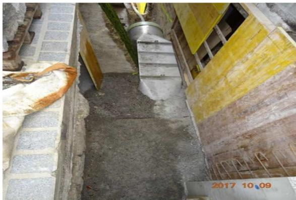
Infolge der tiefer liegenden Werkleitungen in der Baselstrasse kam die Leitung zur Querung der Baselstrasse tiefer zu liegen als vorgesehen. Um die bestehenden Sporen der Nachbarliegenschaft nicht zu verletzen, wurde mit einer Stahlrohrkonstruktion der Engpass gemeistert.
