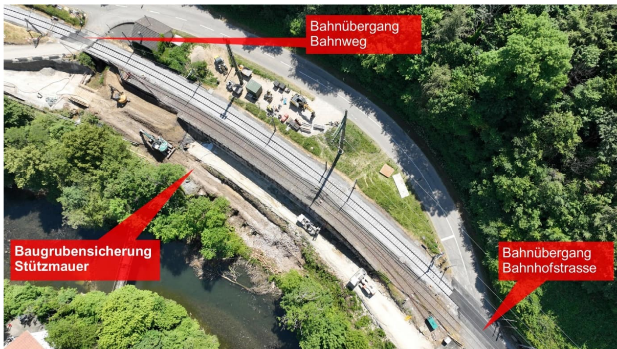
Das Foto vom 13. Juni 2023 zeigt die Arbeiten für die Baugrubensicherung der Stützmauer Bahnweg 1 auf Grellinger Boden (Foto: Martin Andreas Meier).
